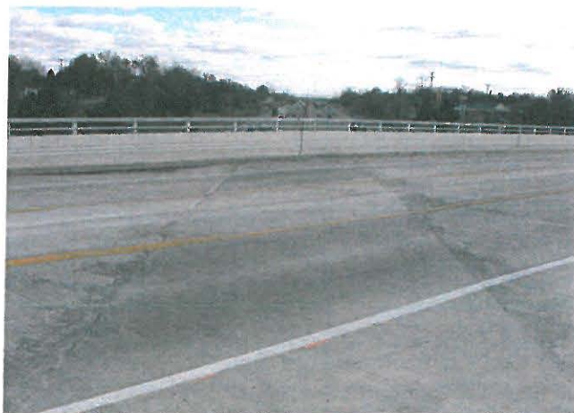
Ein 2005 gegossenes Stück Fahrbahn aus biegsamem Beton auf einer Brücke im Südosten Michigans (oben) schließt sich nahtlos an den Asphalt links und rechts an. Die ECC-Platte übernimmt die Funktion einer herkömmlichen Dehnungsfuge. Während diese Fugen sonst schnell verschleißen, erfüllt sie bis heute ohne jede Reparatur ihre Aufgabe (unten).
